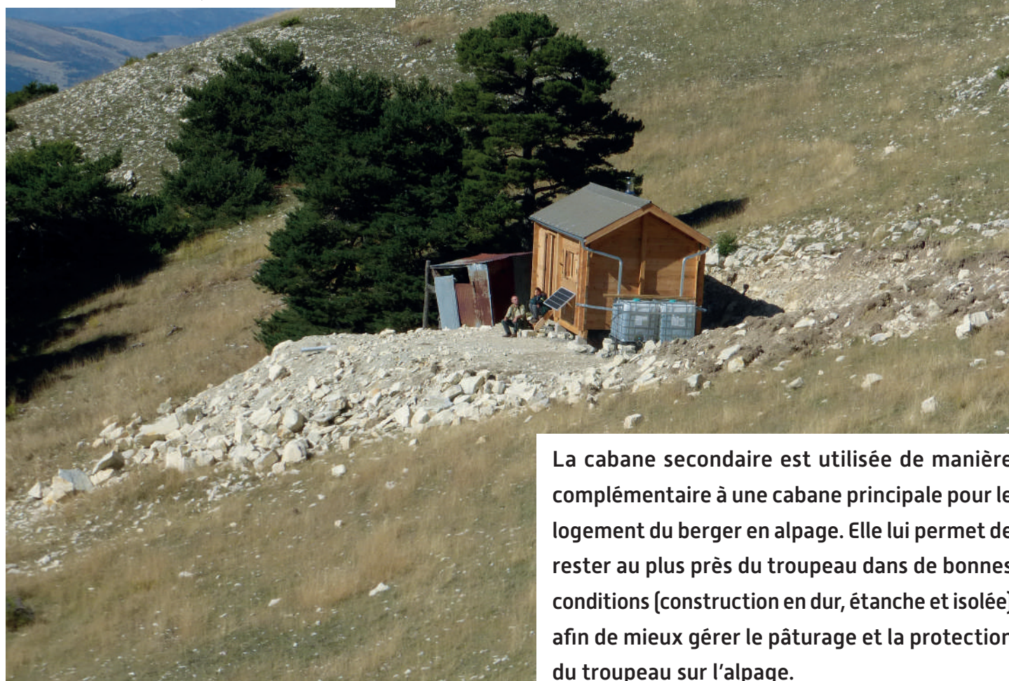
Cabane secondaire avec récupération de l'eau de toiture.
